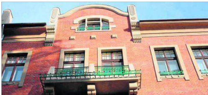
Wyrzście cegły w ścianach, kamienne obramowania okien i żelazne balustrady wyglądają pięknie
